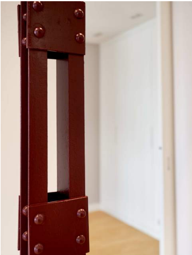
Detalle pilar roblonado
